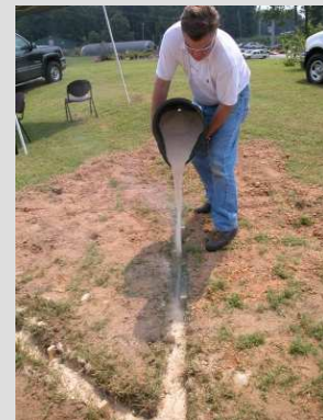
Installing Sand back fill
