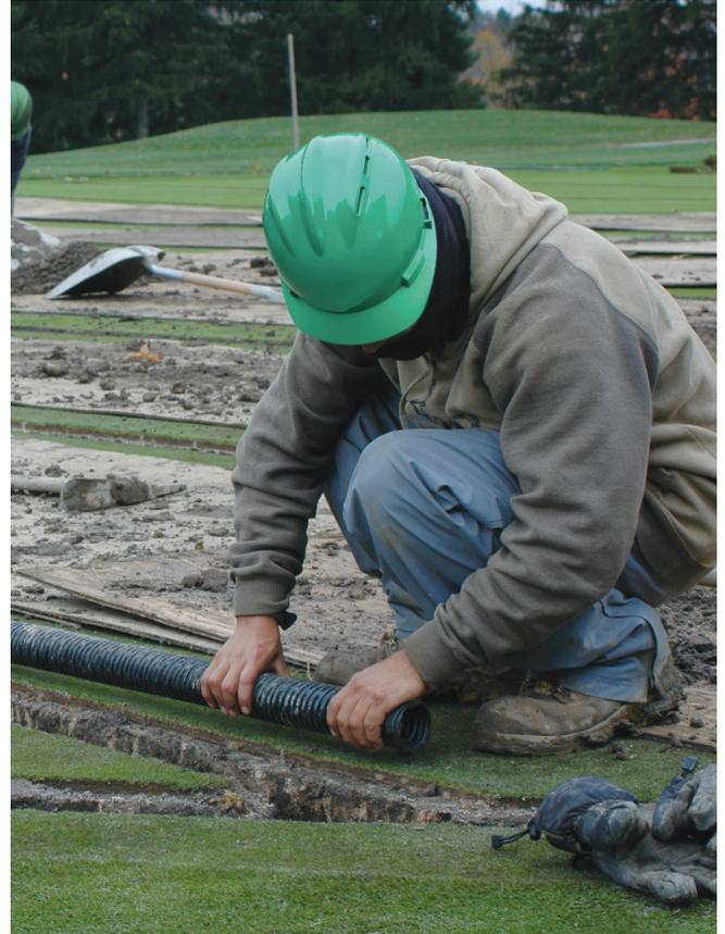
**NOTE: NEVER CONNECT BUNKER LINES TO ANY PART OF THE GREENS DRAINAGE SYSTEM.**
