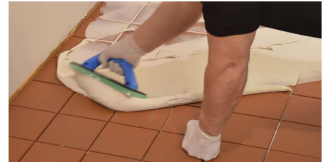
Spreading ARDEX WA
