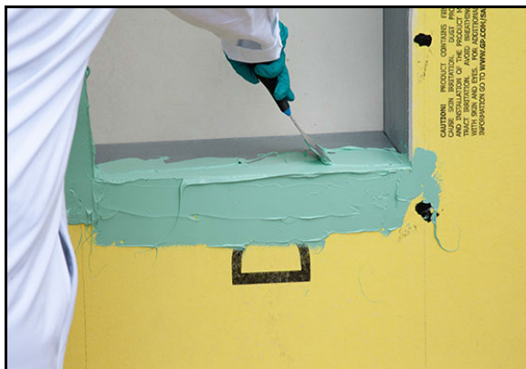
Figure 1: Application du solin en silicone liquid DOWSIL™ 778.
