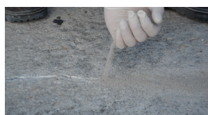
Remplissage et finition
