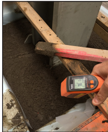
Monitoring Exotherm After Single 36" Pour
