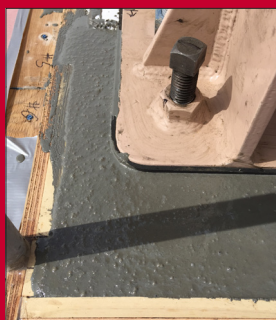
Pouring the DP Epoxy Grout PG
