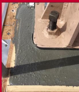
Pouring the DP Epoxy Grout PG
