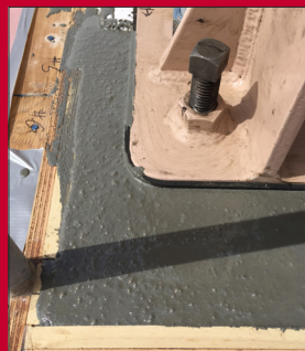
Pouring the DP Epoxy Grout PG
