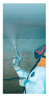
ROOF COATINGS: FLUOROPOLYMERS
