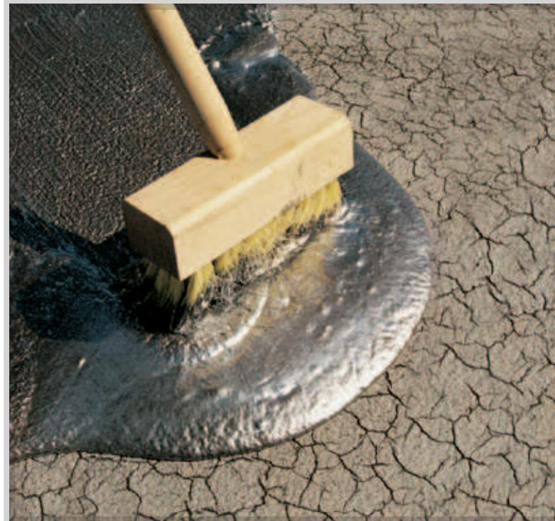
**Usos:** Para recubrir techos de capas de superficie lisa, membranas bituminosas modificadas, láminas de asfalto en rollo y techos de metal.
