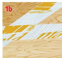
Utilice la cinta IKO GoldSeam para sellar las marcas de la cubierta. Las juntas en las que los paneles de madera contrachapada o de OSB se topan entre sí en la cubierta del techo deben estar selladas correctamente. Una vez que las marcas hayan sido pegadas con cinta adhesiva, usted puede continuar cubriendo la cubierta con el impermeabilizante sintético de IKO. Recuerde usar el protector de hielo y agua de IKO en áreas requeridas por el código.
