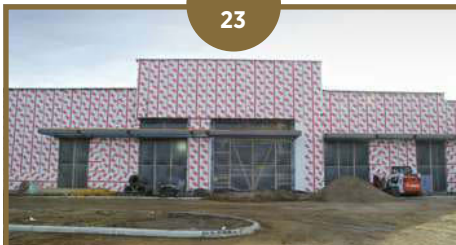
Air & Vapour Barrier
