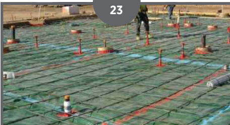
Underslab Vapour Barrier
