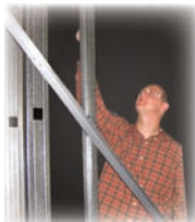
Ejemplo de apuntalamiento (bracing)
