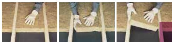
Se corta con rapidez y precisión con un cuchillo serrado, como los cuchillos de pan, de modo que puede lograr un ajuste óptimo fácilmente alrededor de tuberías, cajas de electricidad, cables, ductos y entre los listones y vigas que tengan un ancho que no sea estandar.
