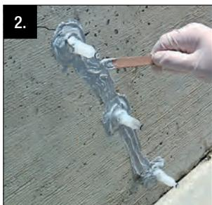
3. Permita que el empaste se endurezca antes de comenzar con la inyección. **Nota:** CI-PO y ETR son de curado rápido y pueden endurecerse prematuramente si se mezclan manualmente y se dejan en forma mezclada en la superficie de mezcla mientras se instalan los puertos. Si esparce una capa delgada de empaste (aproximadamente 1/8") sobre la superficie de mezclado, permitirá que el calor de la reacción se disipe y, en consecuencia, ralentizará el tiempo de curado.
