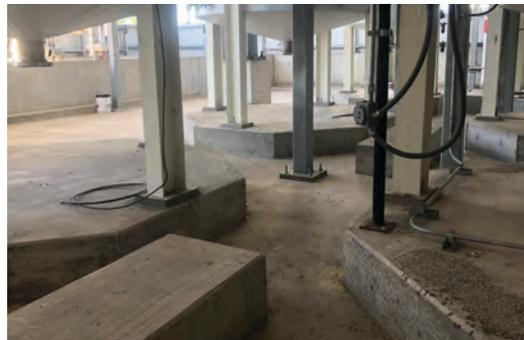
Entorno medianamente corrosivo típico: anclaje exterior.
