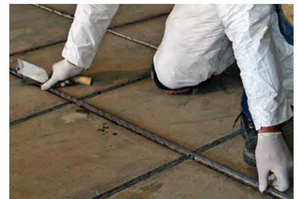
Refuerzo de FRP instalado cerca de la superficie
