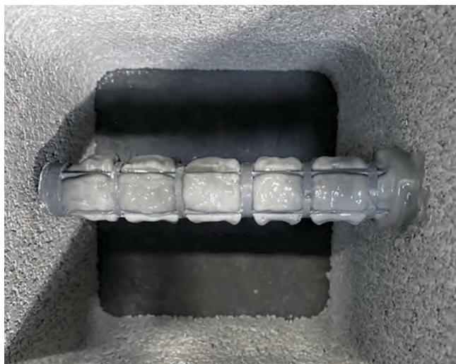
Los agujeros especialmente dimensionados en las mallas Opti-Mesh permiten que el adhesivo se filtre en el lugar adecuado de la sección hueca de las CMU (concrete masonry units, unidades de mampostería de concreto) para mejorar la adhesión a la capa protectora.
