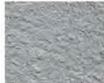
CSP 5 (Medium Shot blasting)
