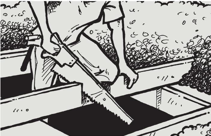
**IMPORTANTE:** Esta es sólo una pauta general, ya que cada instalación es única en cuanto a requisitos de carga estructural, tamaño del marco, separación entre vigas, longitud de tramos, tamaño de tragaluz, etc. VELUX no puede responsabilizarse de forma alguna por los métodos de construcción utilizados. Deberá consultarse a un ingeniero o arquitecto si se cortará una viga del techo.
